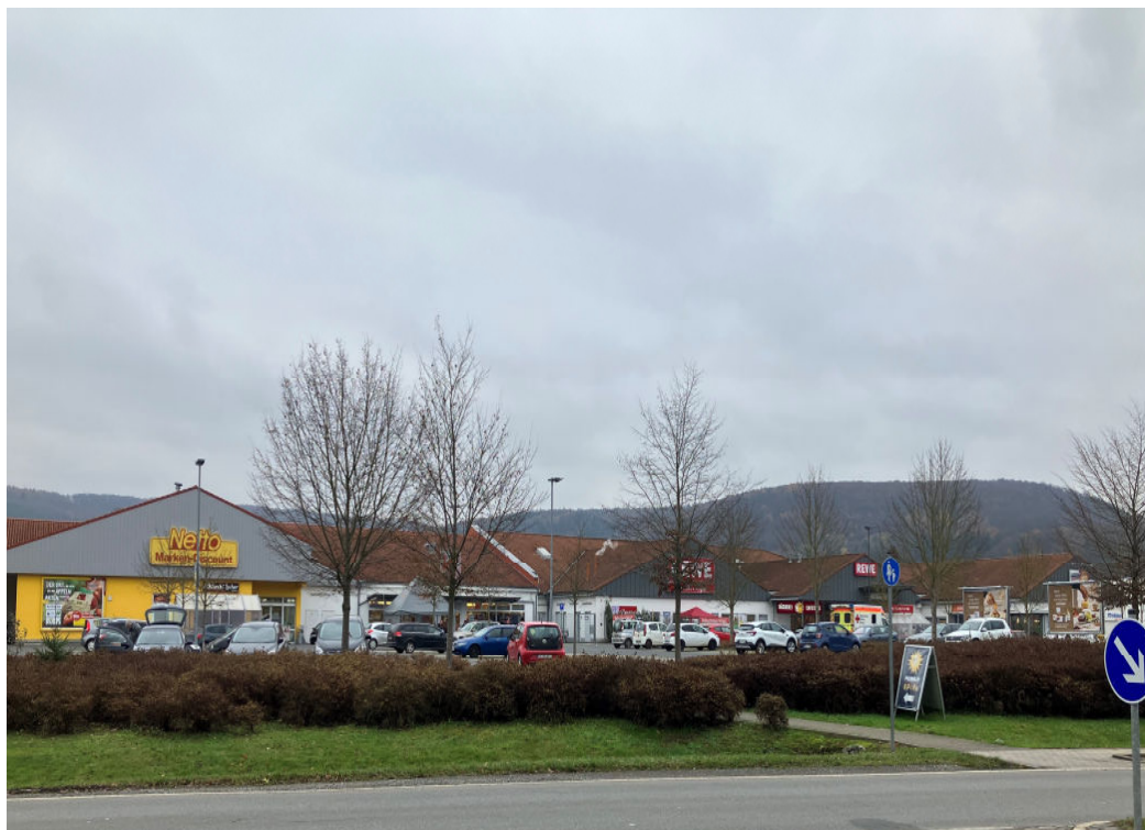
Ansicht der gesamten Anlage
